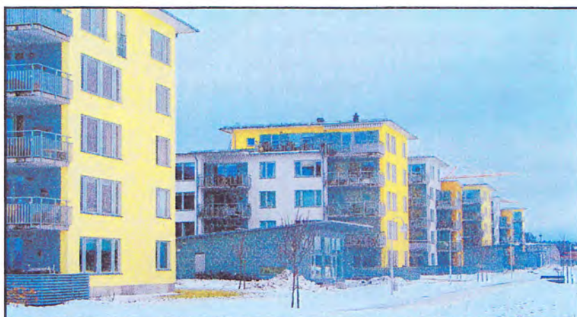
Sydöstra stranden med sex hus mellan hangaren och vattnet.
